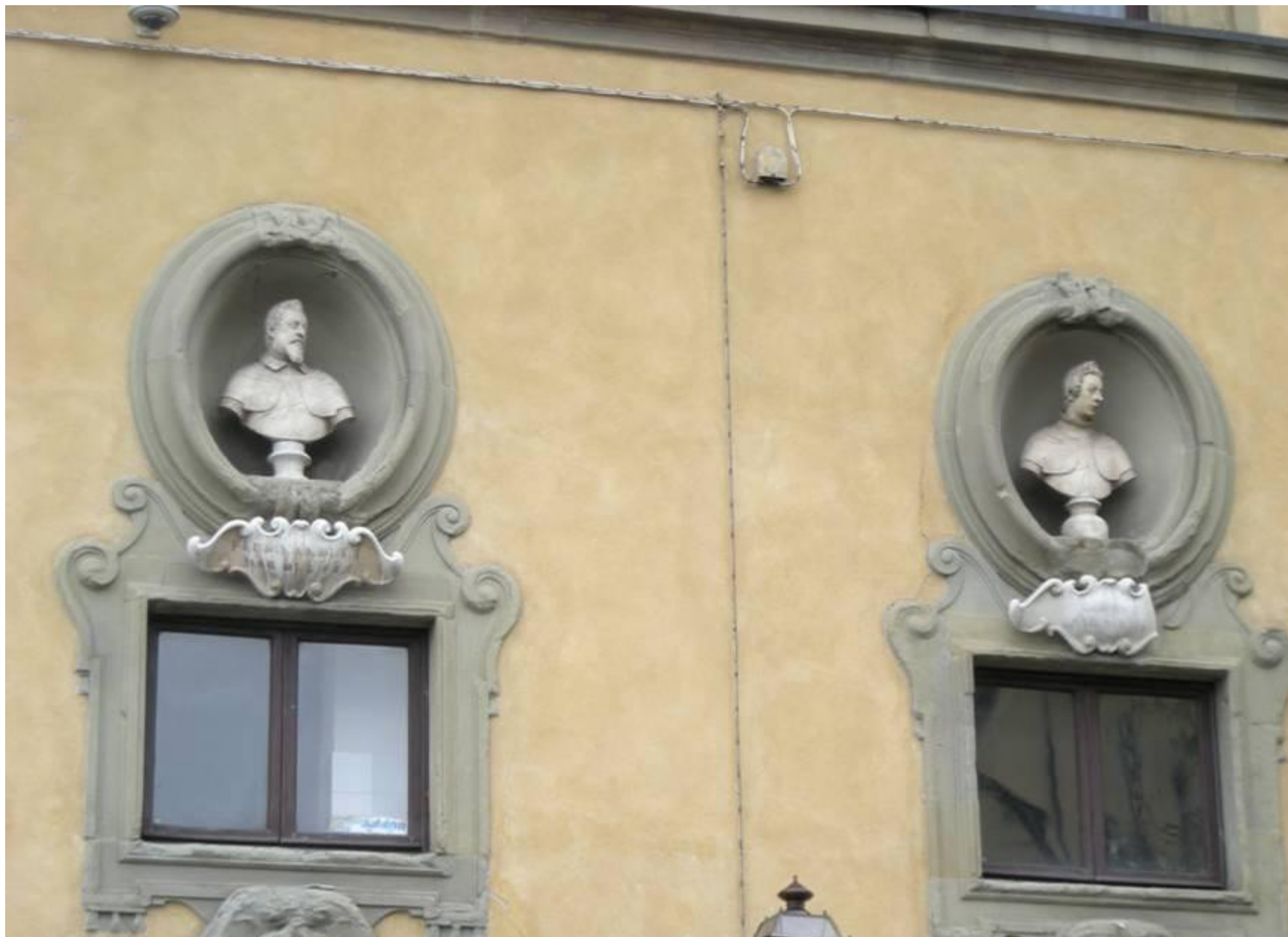
Particolare della facciata, busti dei Granduchi Ferdinando I (1549-1609) e Cosimo II (1590-1621)
